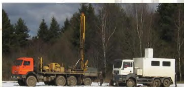
Инженерные изыскания на Островецкой площадке АЭС (2009 г.)
