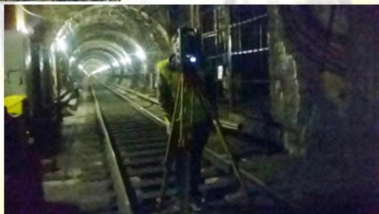
Мониторинг деформаций тоннеля метрополитена (Минск, 2014 г.)
