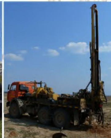
Бурение установкой УГБ-2А2 на площадке БелАЭС (2011 г.)
