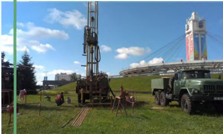
Подготовка к бурению гидрогеологических скважин на площадке проектируемого высотного здания (МФК "Газпром Центр", Минск, 2015 г.)
